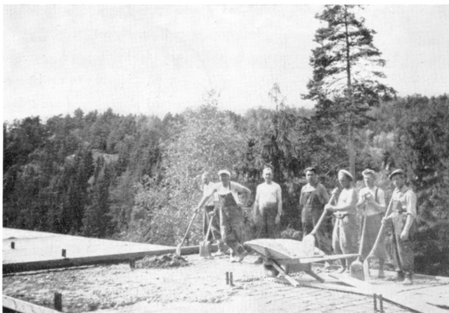
Støpning av stannplassdekket 1950.
