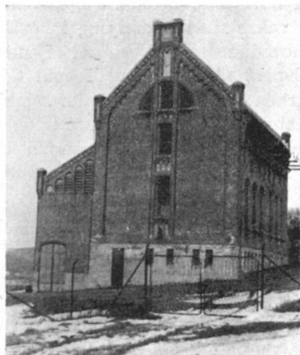
Skien s kommunale Elektrisitetsverks sekundærstasjon, som er tilknyttet Skien sfjordens kommunale kraftselskap. Bygget 1913—14.
