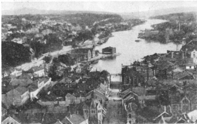
Utsikt over Skiens havn med Bryggevanntet i forgrunnen. Bygningen som stikker frem midt på bildet, er tollboden.
